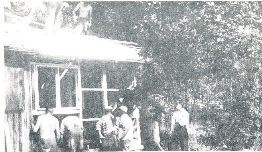
Tillbyggnad av föreningshuset
